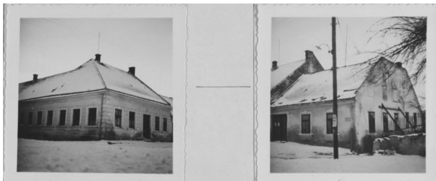
Budovy staré školy - dnes zbouráno
